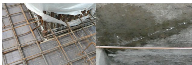
Hình 2. Nứt sàn từ mép vách cứng do co ngót BT và thiếu thép cấu tạo
