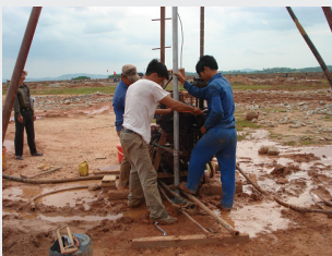
Hình 1. Thi công khoan và lắp đặt mốc chuẩn đo lún
