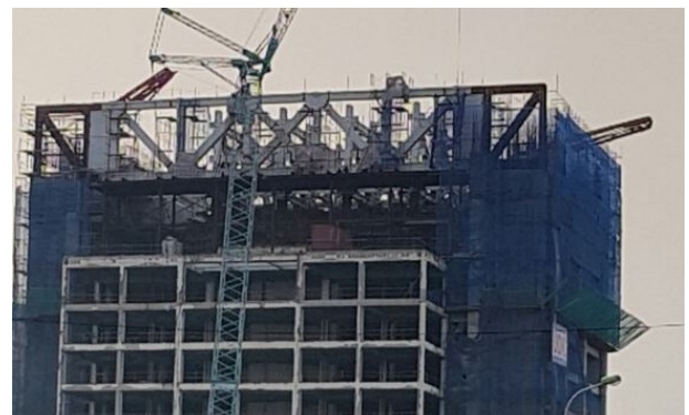
Hình 1: Hệ dầm chuyển kết cấu thép
